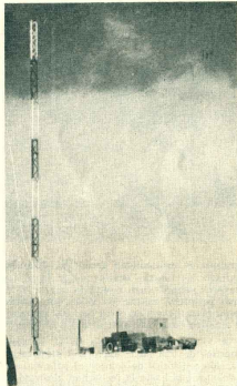
Radiofaro instalado en las proximidades de la pista especialmente construida en la isla Robertson , que sirvió de orientación a los pilotos para "huelizar".
