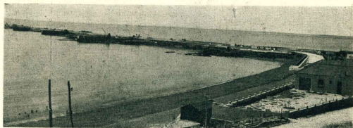
Aspecto del avance del dique viaducto.
