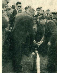
Instante en que el gobernador de la provincia, doctor Mario C. Paradelo, abre uno de los grifos, instalada éste frente al local de la LA ANONIMA.
