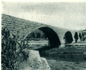
Puente de hornigón sobre el río Percy, en el tramo de lago Futaleufu a Esquel, ruta 258.
