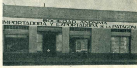
Para atender el suministro de los vecindarios y campaña de Gaiman y Rawson, LA ANONIMA tiene habilitadas sus filiales en ambos puntos. Las fotografías muestran el frente de los edificios que ocupan, respectivamente.
