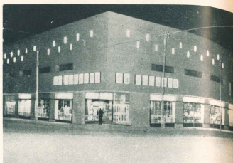
Edificio de la Sucursal de COMODORO RIVADAVIA (Chubut).
