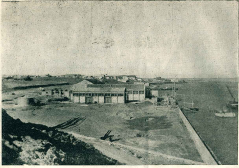
Vista desde la distancia la planta industrial construida y montada por la Compañía Pesquera Atlántico Sur en Puerto Deseado, y parte del muelle de atraque de las embarcaciones pesqueras. La inauguración de este moderno establecimiento representa el comienzo de un área industrializadora de las materias primas que brinda la pompa marina austral.
