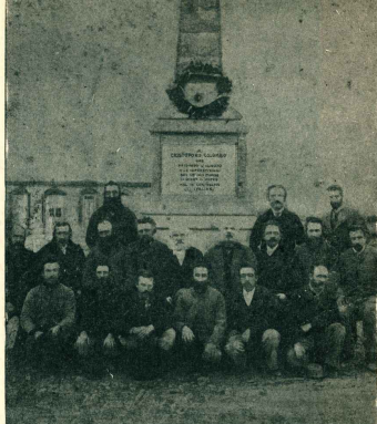
Este es el primer monumento erigido en la Patagonia. Está dedicado a Cristóforo Colombo en el IV centenario del descubrimiento del Nuevo Mundo. Lo hicieron construir galeses e italianos, mancomunados en un mismo ideal ferroviario de progreso, en Gaimán, donde se conserva. En la fotografía aparecen los autores de la iniciativa, que ya pertenece a la historia regional.
