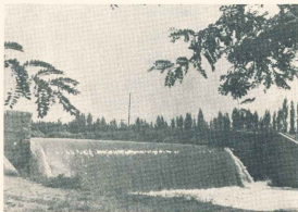
El ingeniero Juldán Romero (1856-1929) fue profesor, diputado nacional e irrigador. Su nombre ha sido dado a la central de 9.000 kilovatios situada en Cinco Saltos, cuyo edificio figura a la derecha, y arriba el salto generatriz.
