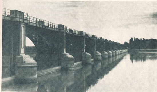
Las cavalletes para el riego que Agua y Energía proporciona a toda la zona del Alto Valle del Río Negro, son derivadas por el dique Nivelador, llamado Centralizante Cordero, emplazado en aquella provincia sobre el río del mismo nombre en Barda del Medio. El Neuquén y el Limay en su fusión originan el caudaloso Río Negro. La fotografía corresponde al dique nivelador referido.
