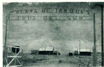
Entrada a la Planta de Tanques Cruz del Sur.
