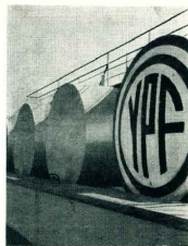
Tanques de la planta "Antares", ubicada en Río Grande.
