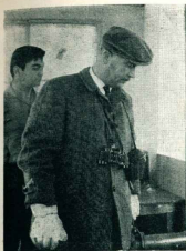
El gobernador de Tierra del Fuego, haciendo girar la vitruva que puso en funcionamiento la Planta Cruz del Sur.
