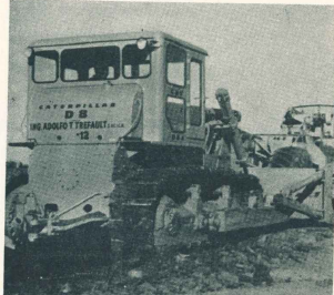
...que conducidos por la empresa Ing. A. Trefault, ya están construyendo la Ruta 3 en Río Grande (Tierra del Fuego).
