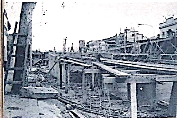
Otro aspecto de las obras para el Puente carretero
