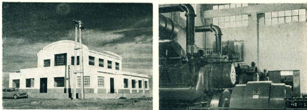
Al habilitar sus servicios la Cooperativa Eléctrica Ltda. de Puerto Madryn, ha quedado resuelto el problema energético que afectaba a esa población. La inauguración del nuevo local de la usina y la puesta en marcha del servicio, han merecido la complacencia del vecindario que interviene con simpatía en los actos desarrollados. En la foto superior, vemos el local que ocupa la usina, y a la derecha un enjoe de una de sus maquinarias.
