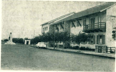
Edificio de Correos y Telégrafos en Rawson. Al fondo de la calle, el monumento al general Roca.
