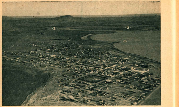
Fig. 8. 1.—Punta Caldera, 2.—Banco Cormorán, 3.—Cabo lateral. (Fotog. del Ministerio de Marina.)
