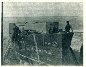
El "Nannucurá" durante su construcción, en Santa Cruz.
