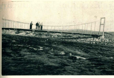
El río Senguer pasa por el campo de la estancia "Pepita", situada en Alto Río Senguer. Para el movimiento de hacienda entre los dos sectores seccionados por el río, ha sido construido un puente colgante que muestra la fotografía, de 60 metros de luz, 1,30 de ancho y 0,50 de altura sobre la creciente máxima registrada en el río Senguer, que lo fue en el año 1930. La S.A. Estancias Mauricio Braun confió el proyecto del puente al Ingº Obdulio Ricci y la construcción estuvo a cargo de la empresa Callejero y Ricci
