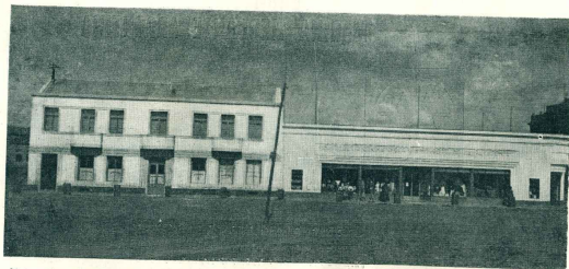
Nota sobresaliente en el marco edificio de San Julián es el edificio que ocupa la Sociedad Anónima Importadora y Exportadora de la Patagonia. Frente a este funciona un anexo también de moderna y amplia construcción.
