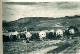
Grupos de casas nuevas, situadas hacia el fondo de la parte industrial del municipio, sobre las márgenes del arroyo Santa Florita.
