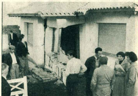
Otra vivienda de material sólido, en Esquel, muestra los efectos de la convulsión terrestre. Son muchas las propiedades que han resultado seriamente dañadas.
