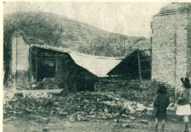
Una vivienda en Esquel prácticamente destruida por la conmoción geológica, que tuvo su epicentro en Chile y fuertes colapsos en la Patagonia.
