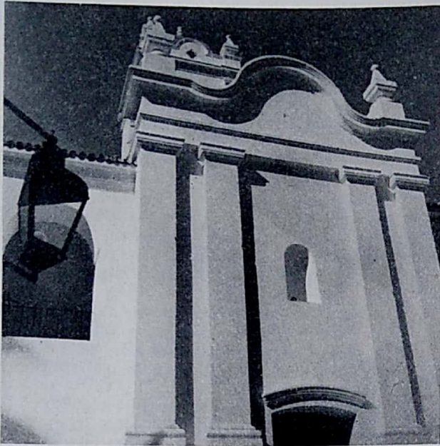
Detalle de la fachada del Cabildo
