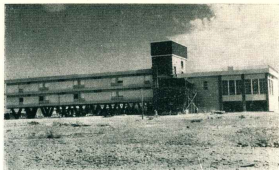
Edificio en terminación para el hotel provincial de turismo en Rawson.
