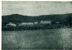
Parte de las instalaciones de la estancia "El Escorial", establecimiento que sobresale por su imponente acción en el mejoramiento del Merino Australiano. Sus productos triunfaron en Sarrieno, donde hubo varios competidores de calidad.
