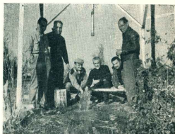
El jefe del aerodromo de Trelew, señor Torres, con el jefe del grupo instalador de la bomba de pozo profundo, señores Zarrillo, y otros integrantes del equipo.
