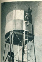
Tanque con capacidad para 10.000 litros, construido por el equipo perforador N° 3 para abastecer de agua al aerodromo de Trelew.
