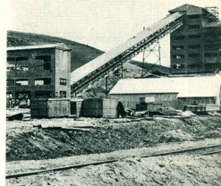
Un aspecto de las instalaciones de Yacimientos Carboníferos Fiscales en Río Turbio, donde ha de incrementarse la actividad si se cumplen los planes previstos en el reciente decreto.
