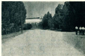
Un camino arbolado y al fondo el paredón del dique.
