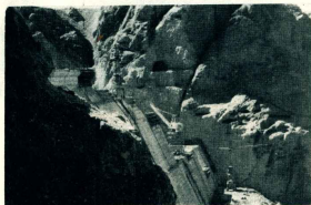
La muralla en construcción entre dos paredes rocosas.
