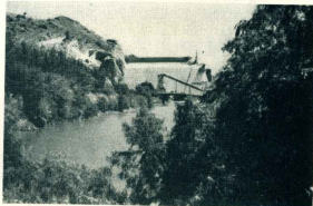
El río Chubut y en el fondo el paredón del dique en construcción.
