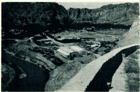
Desde las barrancas, el río y parte de las construcciones de emergencia que utiliza la empresa constructora.
