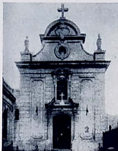
Fachada de la Capilla luego de la restauración
